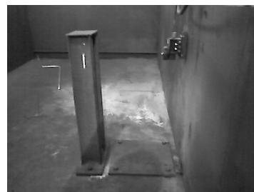
Figura 12 – Fase de montagem das duas vigas paralelas de apoio para o cilindro pneumático.
