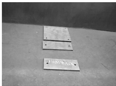
Figura 11 – Etapa de fixação das bases de apoio para as estruturas da máquina.
