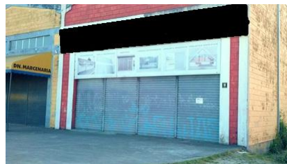
Fachada do galpão para a fábrica Fonte: Os autores
