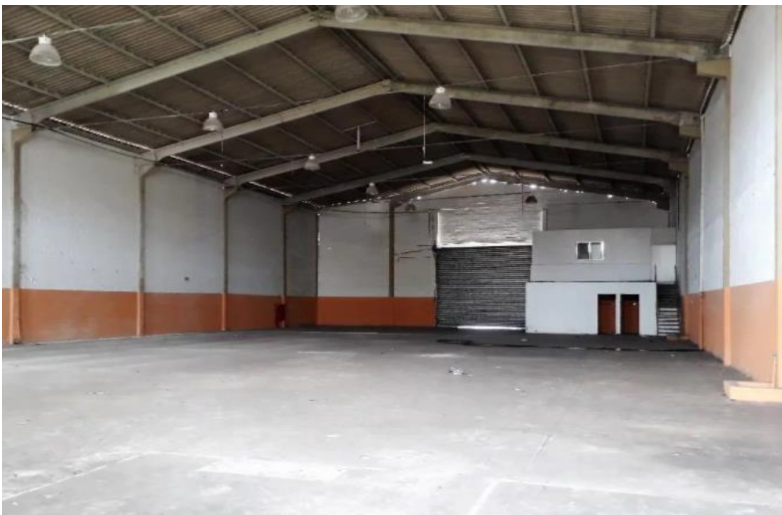
Figura 17: Parte interna do galpão
