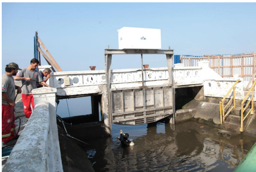
Figura 3 - Instalação das novas comportas dos canais de Santos.
