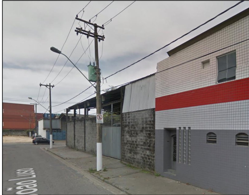
Figura 25 – Vista lateral da fábrica da BTS.
