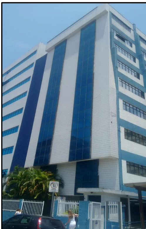
Figura 13 - Edifício Leonilde e Sylvio Pirillo – Vista Frontal
