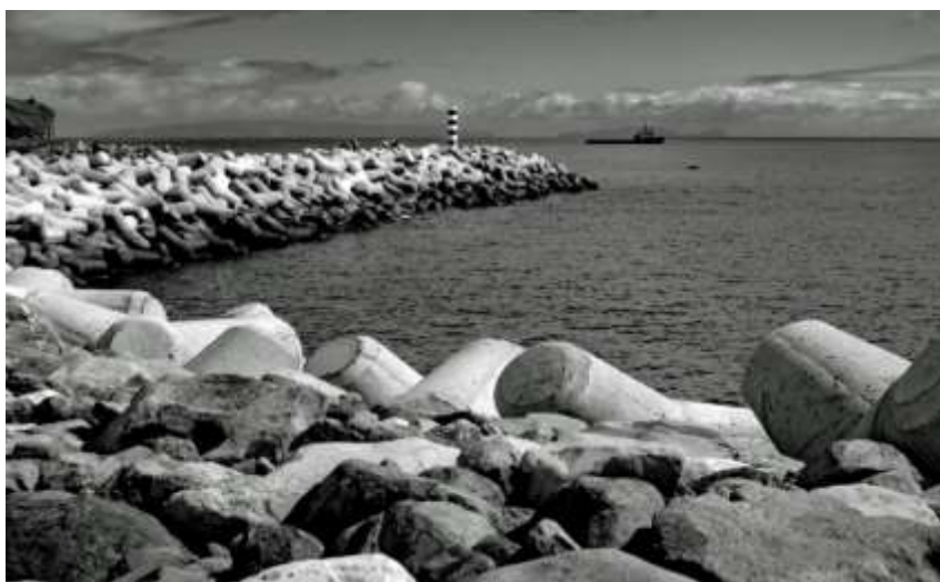
Figura 43: Quebra-mar com concreto tetrápode.
