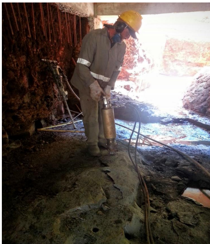
Fonte: MASTER PERFURAÇÕES & DESMONTES, 2017.
