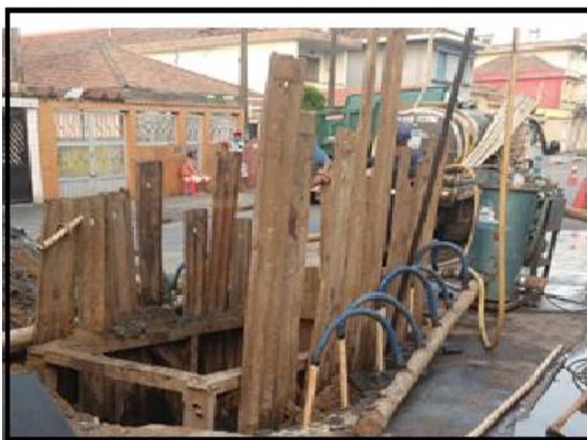
Figura 16 - Rebaixamento de Lençol Freático.
