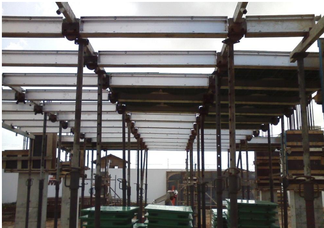
Figura 9: cimbramento metálico com longarinas metálicas
