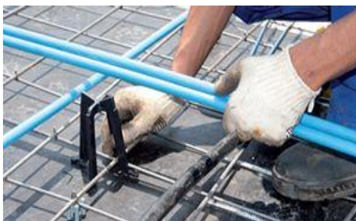
Figura 13: cordoalha sendo alocada sobre espaçador
