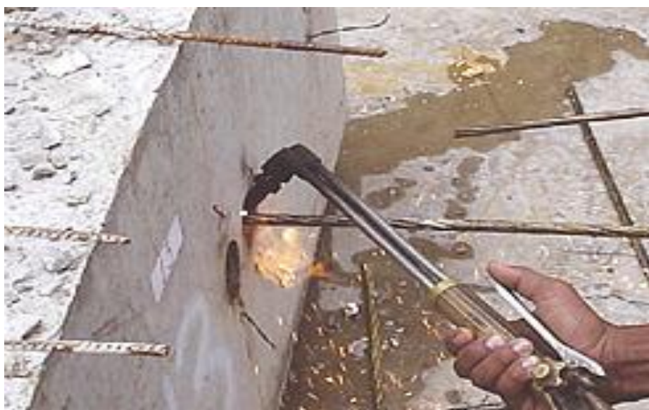
Figura 17: corte das cordoalhas
