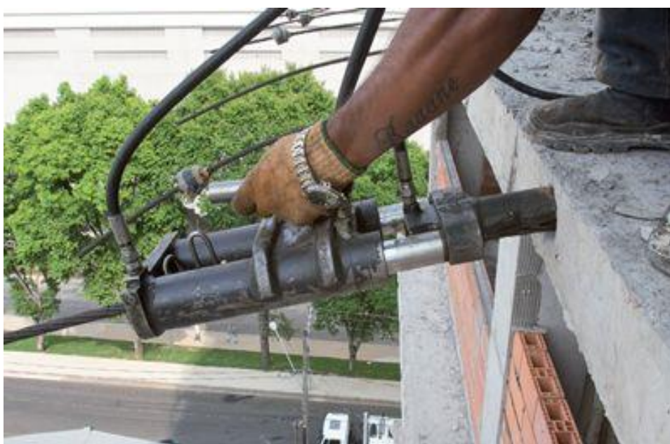
Figura 16: macaco hidráulico executando a protensão
