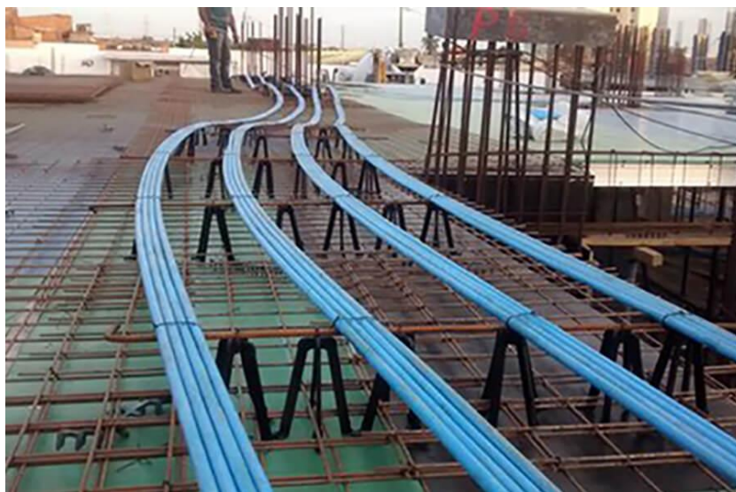
Figura 15: cabos posicionados para organização
