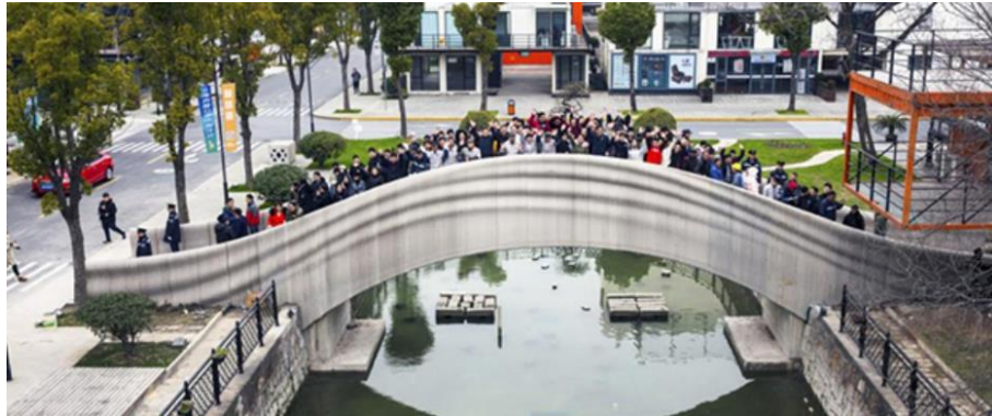
Figura 23 - Ponte impressa em 3D na China.
