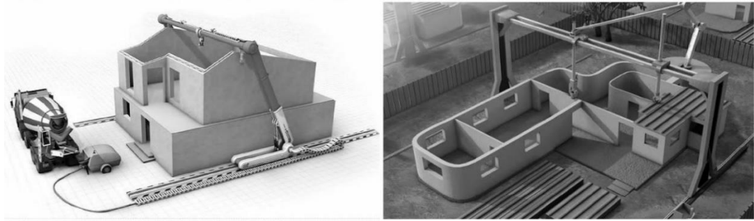
Figura 15 – Representação sistema de Contour Crafting.
