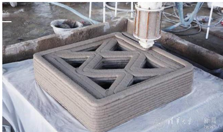
Figura 24 - Blocos de concreto impressos.
