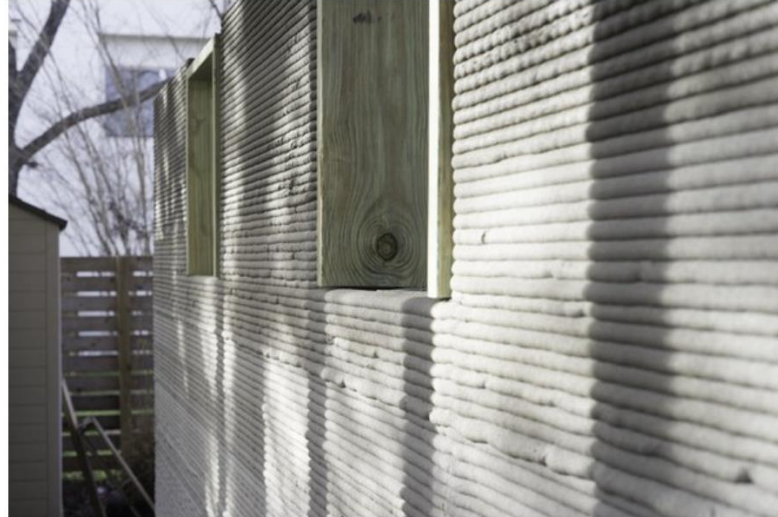
Figura 26 - Detalhes de uma casa impressa com a Vulcan (Tectudo, 2018).
