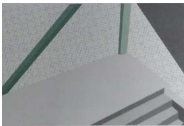
Figura 63 – Proteção provisória de escada externa, com rede
