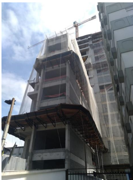
Figura 29 – Tela fachadeira e plataforma de proteção primária
