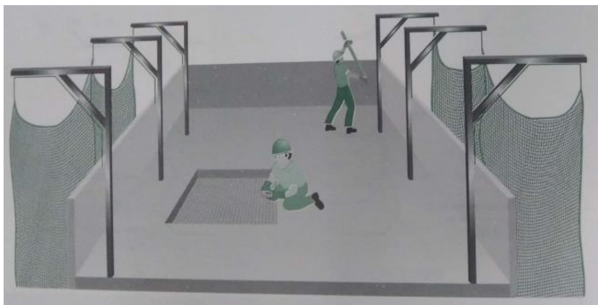
Figura 22 – Suporte de tela fachadeira tipo "forca"
