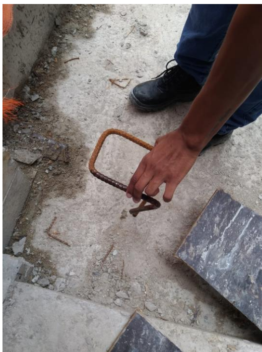
Figura 35 – Gancho de ancoragem da tela fachadeira
