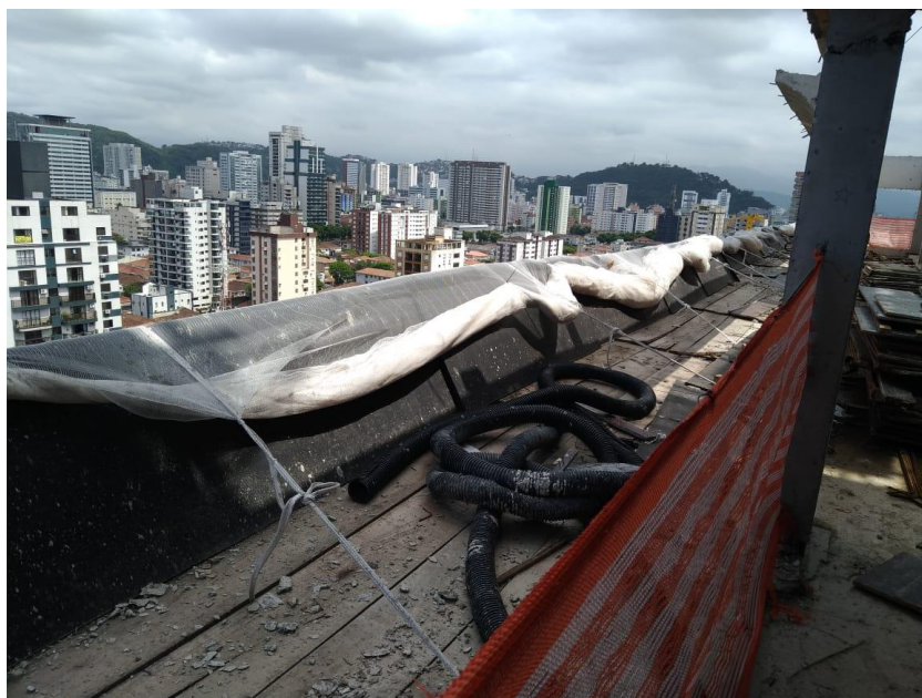
Figura 33 – Ancoragem da tela fachadeira na estrutura da edificação em pavimento intermediário
