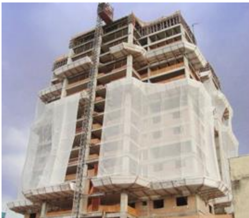
Figura 19 – Tela fachadeira em pavimentos intermediários
