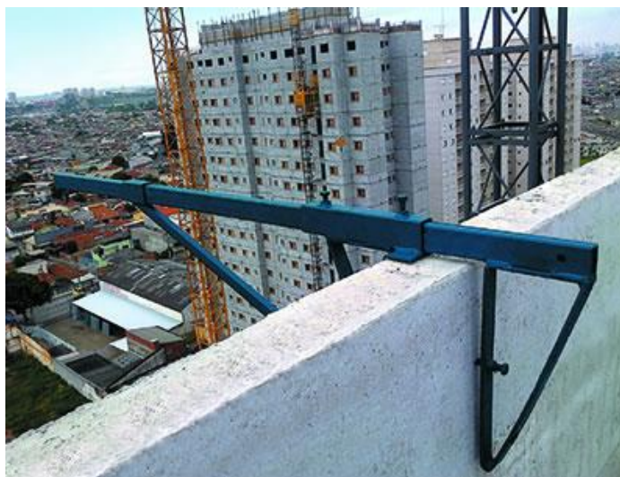
Figura 26 – Fixação da tela fachadeira com suporte ancorado em platibanda
