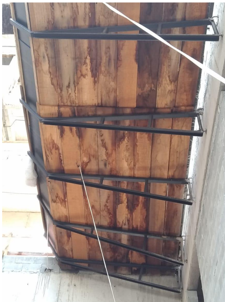
Figura 39 – Vista inferior da plataforma de proteção principal e cordas de fixação
