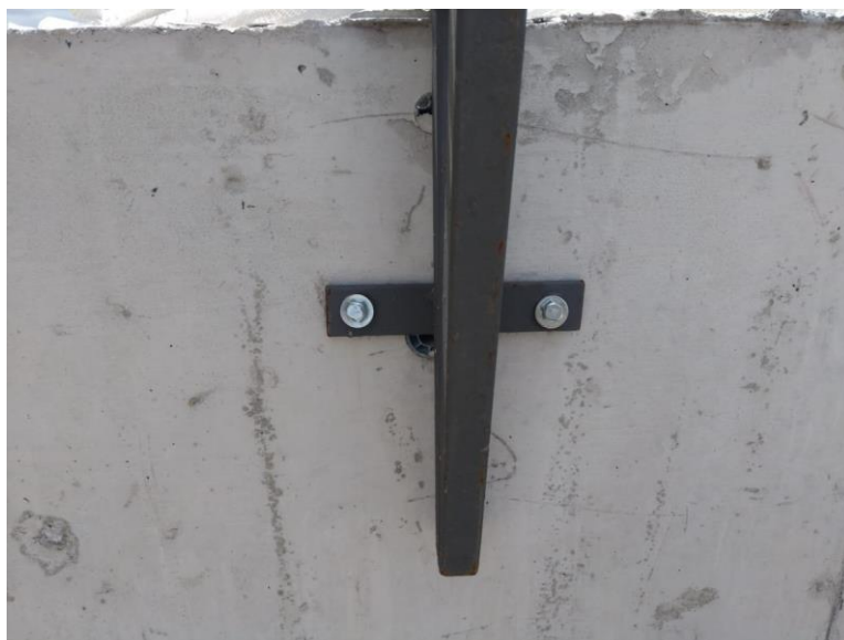
Figura 36 – Chumbamento do suporte metálico da tela fachadeira
