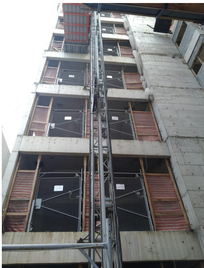
Figura 42 – Equipamentos de proteção coletiva em região de elevadores cremalheira
