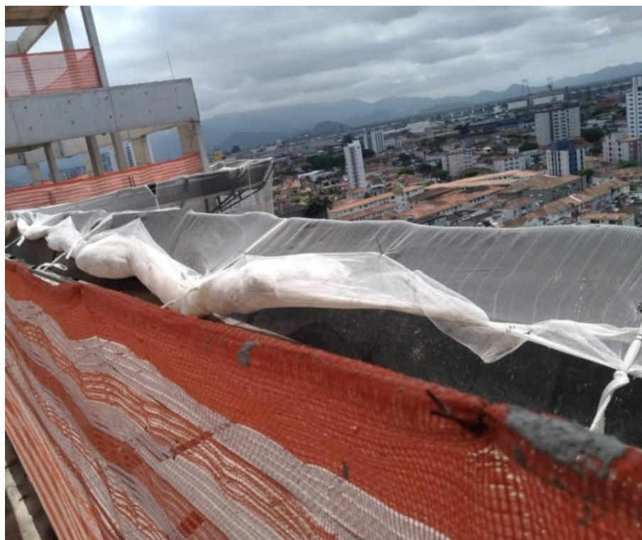
Figura 34 – Tela fachadeira amarrada esperando o suporte superior de ancoragem.
