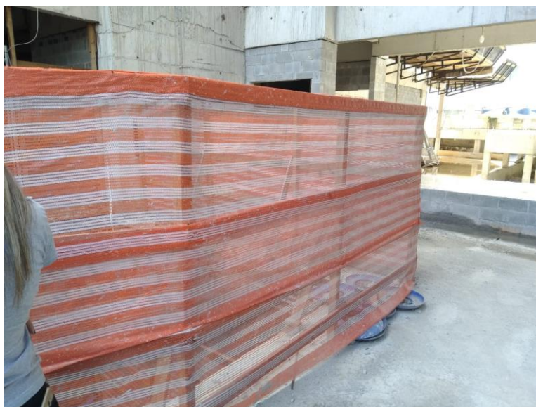
Figura 41 – Guarda-corpo para vãos de transporte vertical de equipamentos
