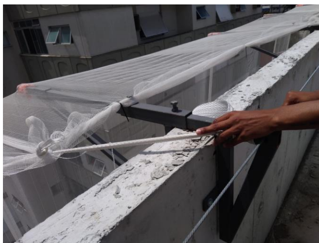
Figura 37 – Suporte metálico e fixação da tela fachadeira
