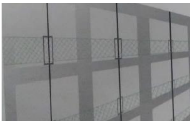
Figura 78 – Fechamento da periferia com estrutura metálica e tela
