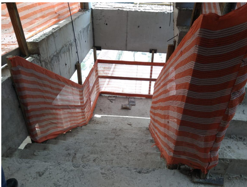
Figura 44 – Guarda-corpo em escadas de concreto
