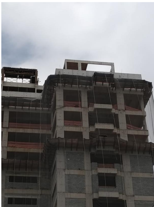
Figura 30 – Tela fachadeira e plataformas de proteção secundárias
