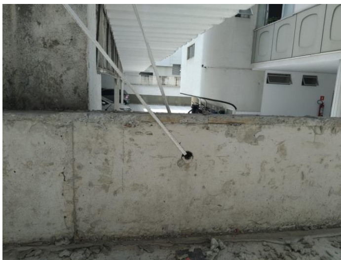
Figura 40 – Amarração na parte inferior da edificação
