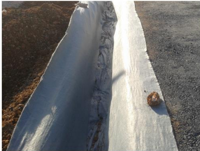
Figura 15 – Escavação e Instalação da Manta Geotêxtil
