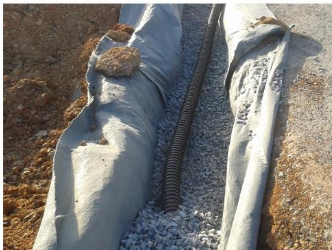
Figura 16 – Instalação do Tubo Dreno
