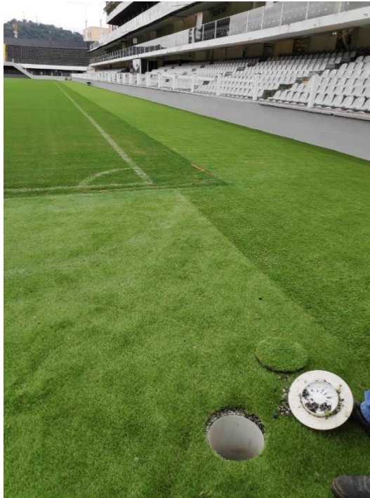
Figura 22 – Tubo de inspeção
