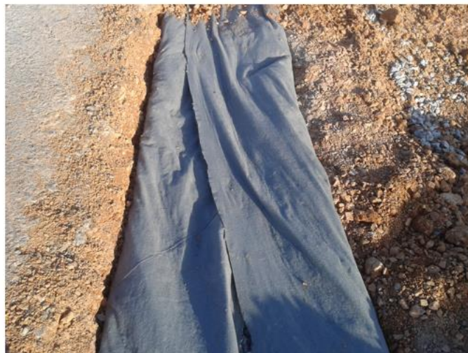
Figura 18 – Cobrimento com a Manta Geotêxtil
