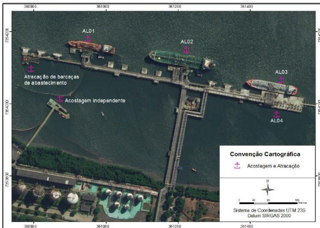
Figura 11 - Infraestrutura de acostagem do TEGLA.
