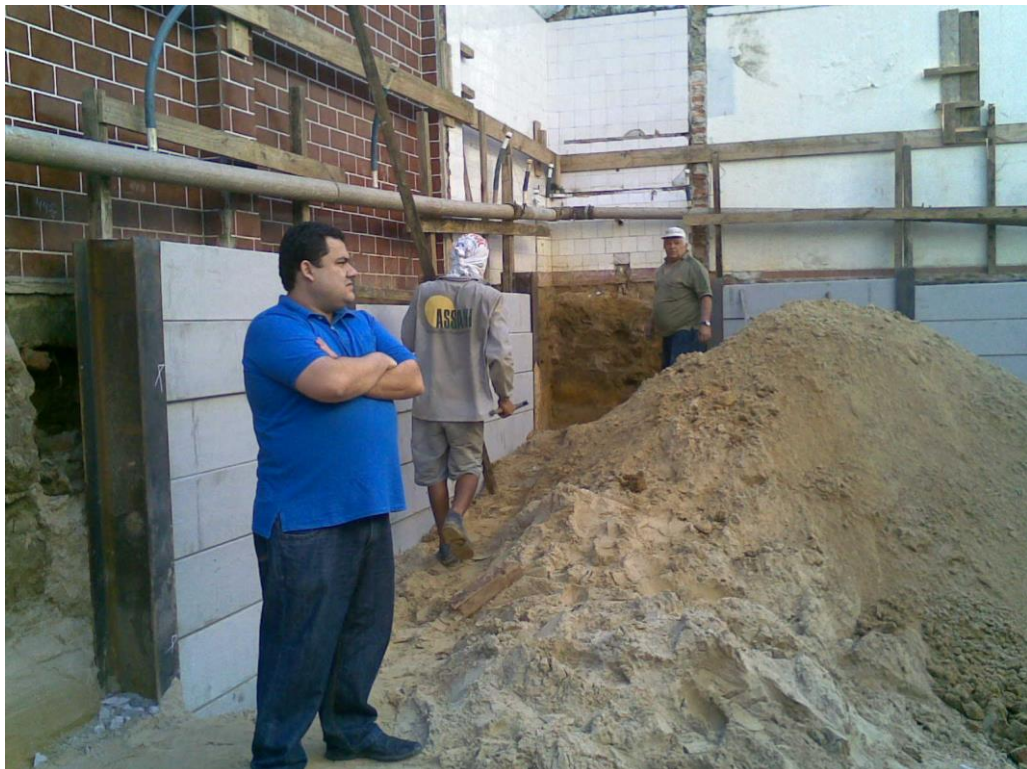
Figura 12- Escavação cortina dupla de concreto armado
