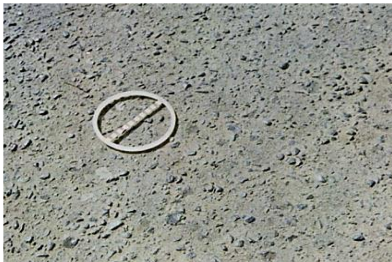
Figura 7 – Desgaste. Fonte: DNIT (2003)
