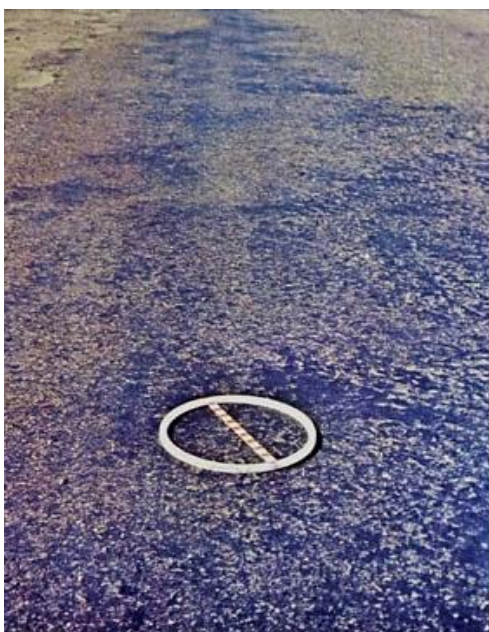
Figura 6 – Exsudação. Fonte: DNIT (2003)
