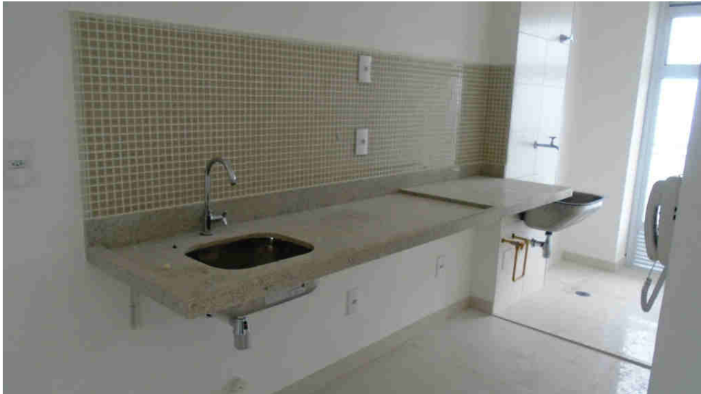
Figura 21 - Ambiente finalizado com bancada e revestimento cerâmico (Yuny, 2016)
