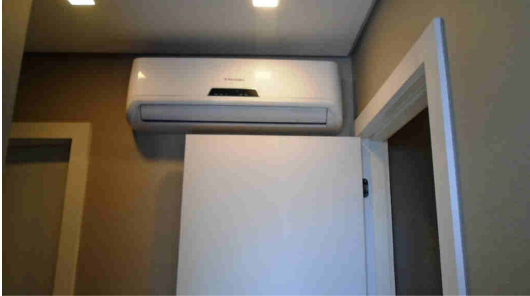
Figura 23 - Ambiente finalizado – Ar condicionado e porta instalada (Yuny, 2016)
