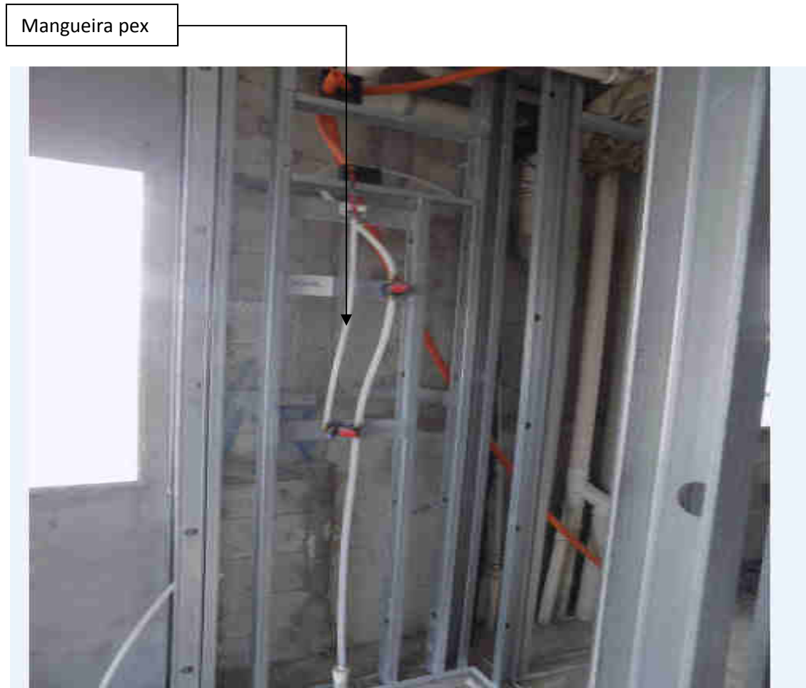
Figura 9 - Rede hidráulica (Associação Brasileira do Drywall, 2016)
