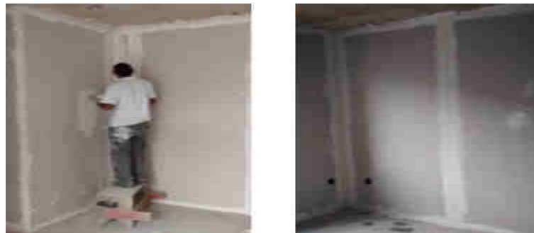
Figura 16 - Tratamento das juntas (Autor, 2016)
