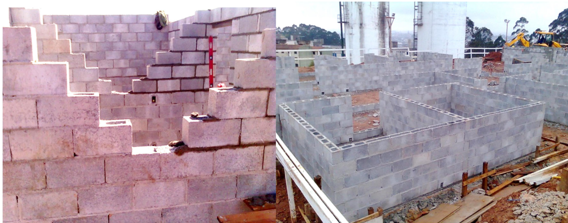
Figura 22: Elevação de paredes (Silveira, 2016)
