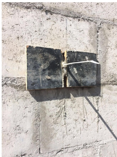
Figura 31: Uso de "fita Hermann" nas caixas de graute (Silveira, 2016)
