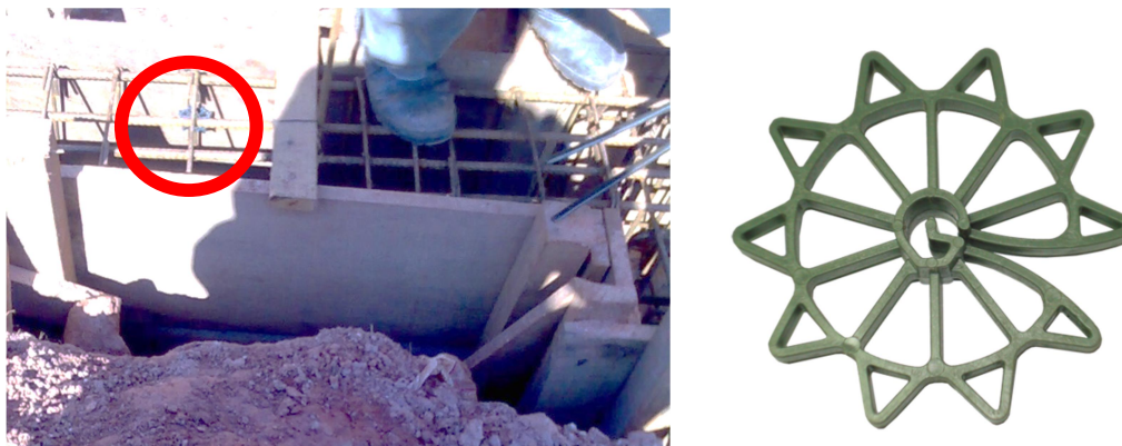
Figura 19: Detalhe do espaçador já colocado na fôrma (Silveira, 2016)
