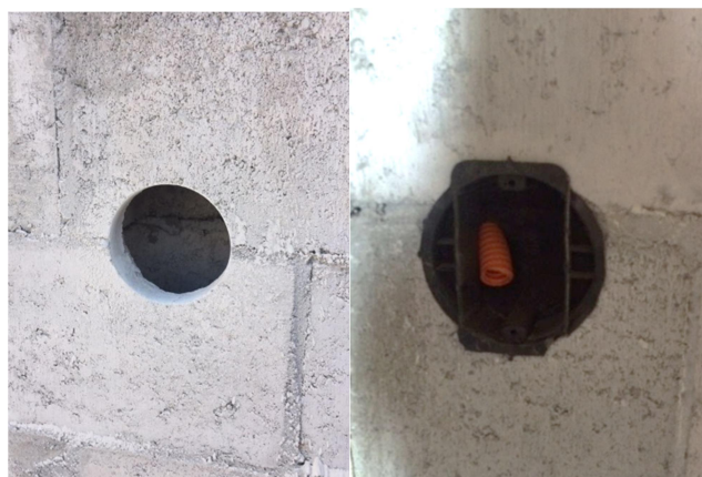
Figura 25: Corte e resultado final (Silveira, 2016)
