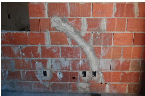
Figura 14: Cortes posteriores na alvenaria (Sousa, 2011)
