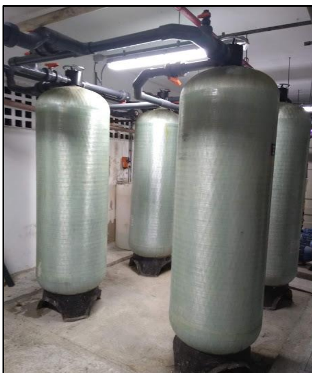
Figura 25 - Processo de filtração da água.
