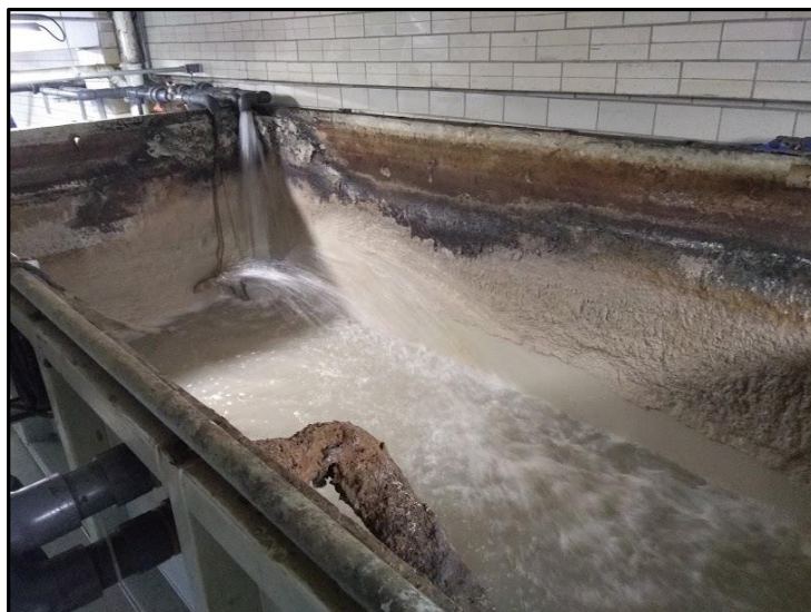
Figura 19 - Vista superior do reservatório de equalização.
