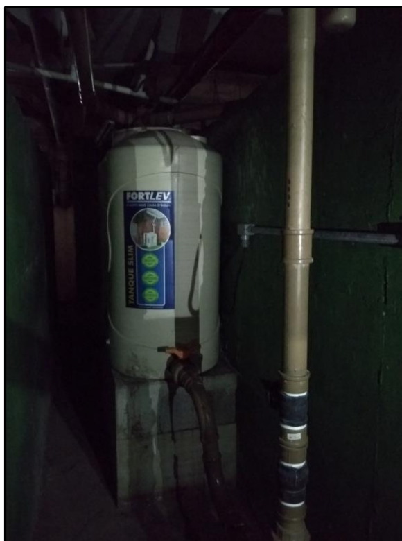
Figura 17 - Reservatório de armazenamento das águas das pias dos banheiros - Pré ETE.
