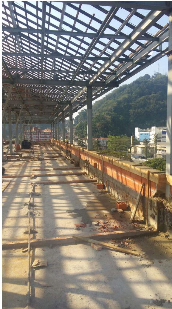
Figura 1 – Estrutura metálica - Início da execução da alvenaria. Foto tirado “in loco” no dia 06/09/2015 em Santos.
