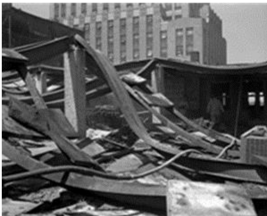
Figura 6 – Escombros de edifício – Estrutura metálica que cedeu devido a um incêndio. –
