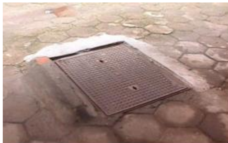
Figura 9 - Tampa do reservatório sem rebordo (Fonte: CAMIOTTI; GONÇALVES, 2002).
