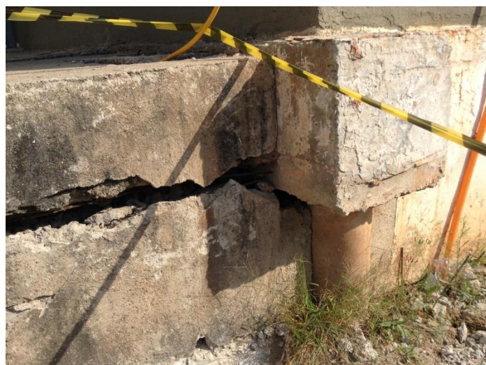
Figura 8 – Recalque no solo (próprios autores).
