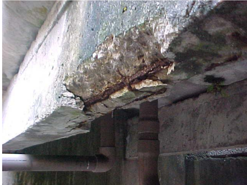
Figura 17 - Viga de sustentação dos reservatórios superiores (próprios autores).
