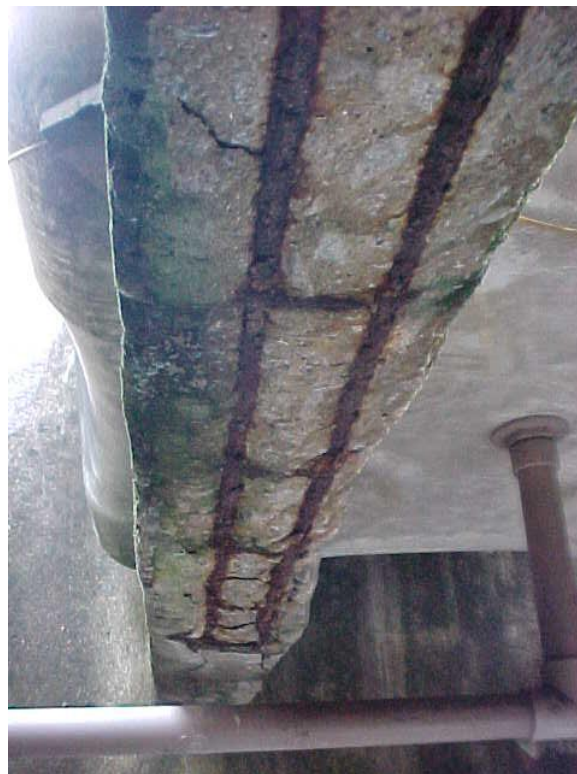
Figura 18 - Viga de sustentação dos reservatórios superiores (próprios autores).
