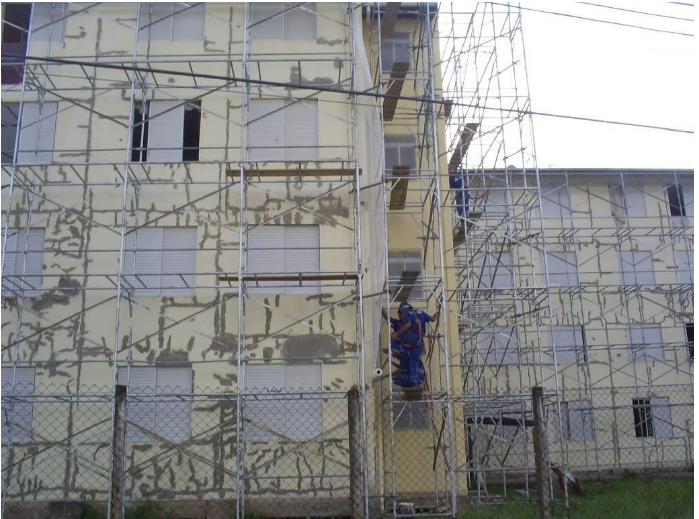
Figura 27 – Recuperação da fachada (próprios autores).
