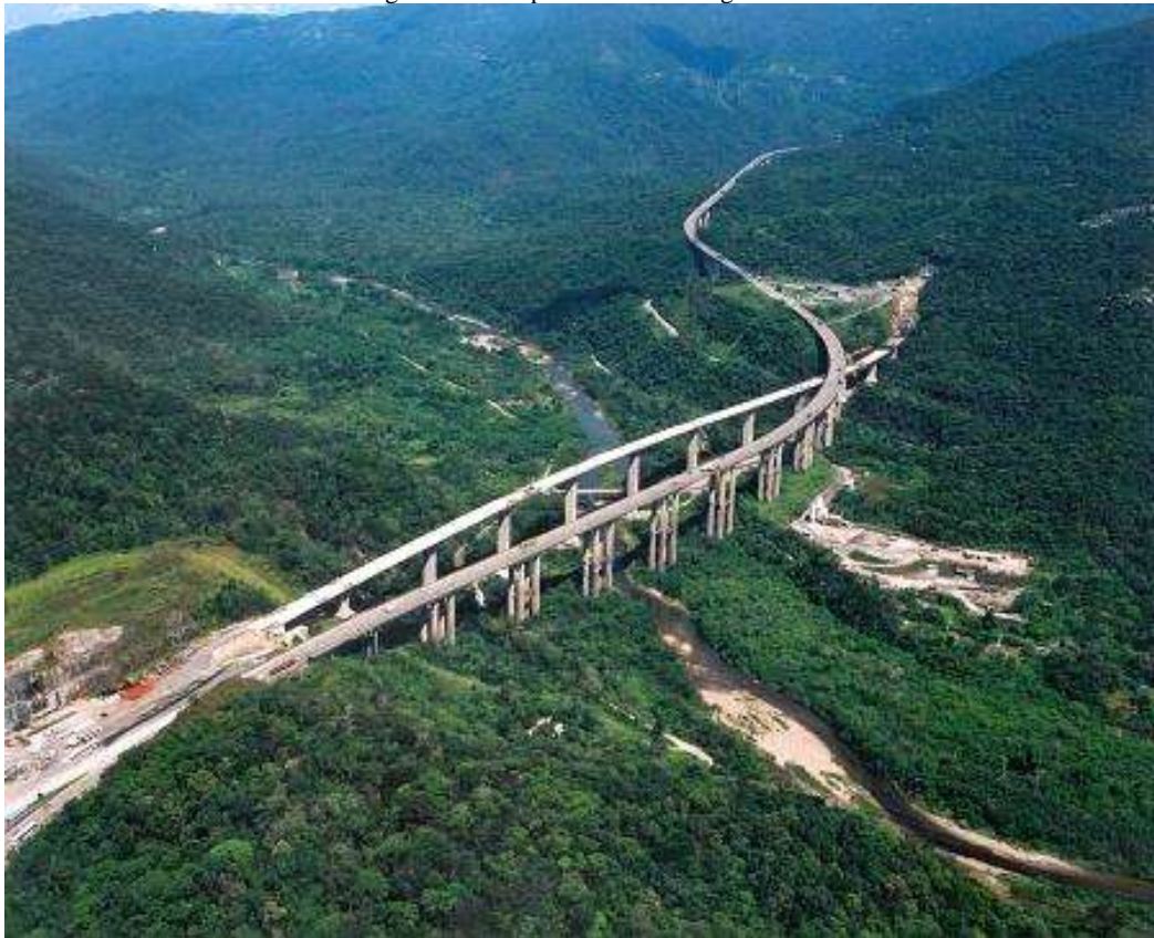
Figura 7: Nova pista Rodovia Imigrantes
