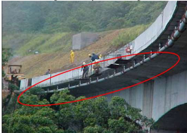
Figura 12: Tubulação metálica - drenagem viadutos
