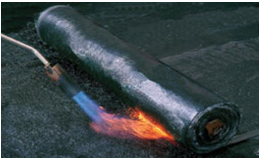
Figura 9 - Aplicação da manta com maçarico
