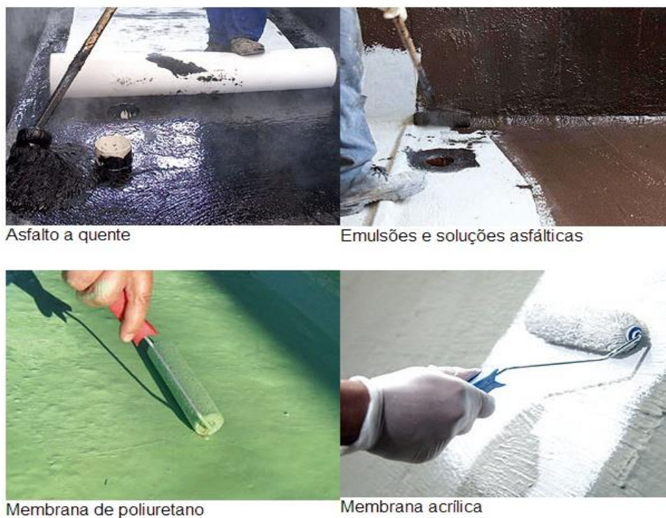
Figura 8 - Aplicação de membranas moldadas no local Fonte: http://blog.construir.arq.br/impermeabilizantes/ (2015)
