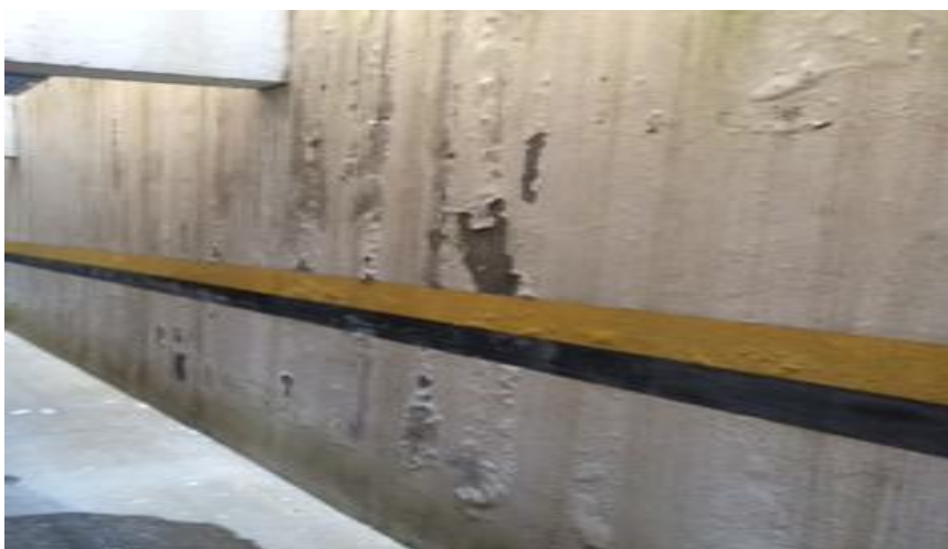
Figura 1 – Água por percolação
