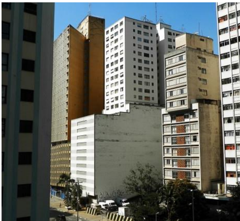
Figura 5 – Edifício - Garagem Saint Patrick
