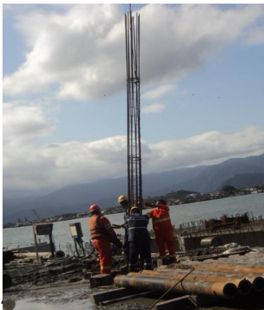
Figura 10: Armação da estaca Fonte: Do autor
