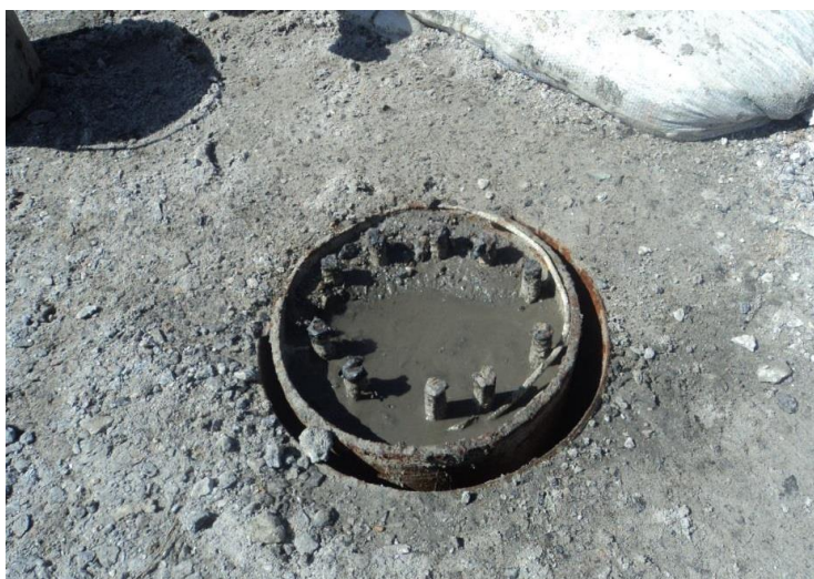
Figura 11: Estaca após injeção de argamassa Fonte: Do autor
