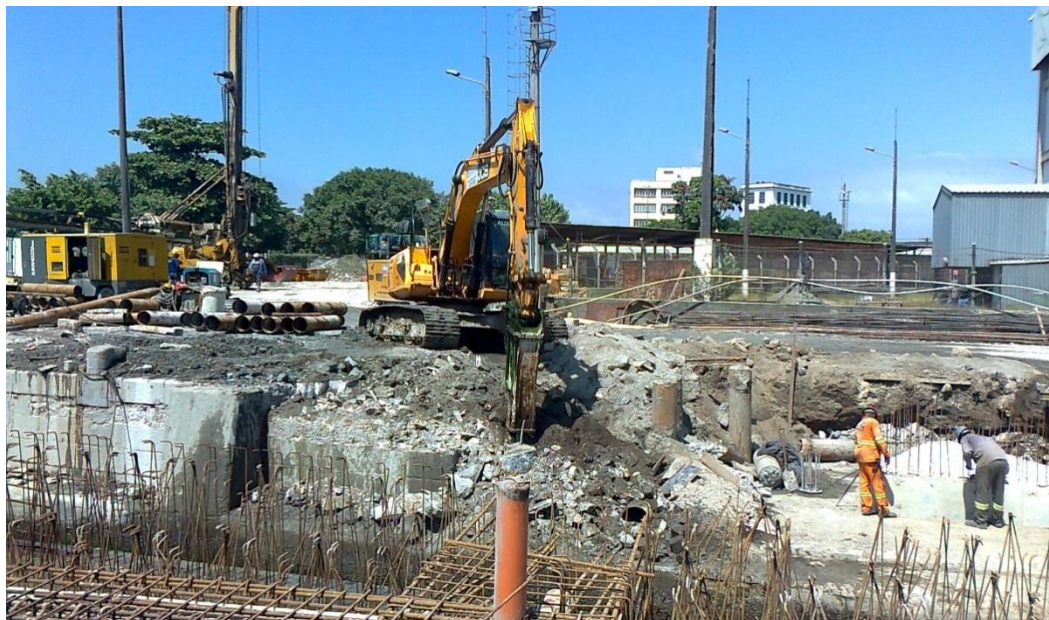
Figura 20: Rompedor hidráulico removendo excedentes em torno da estaca. Fonte: Do autor.
