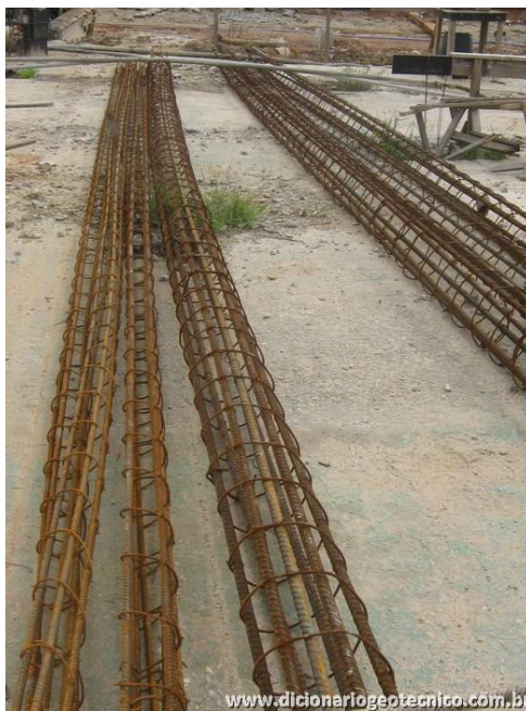
Figura 7: Armadura da estaca raiz
