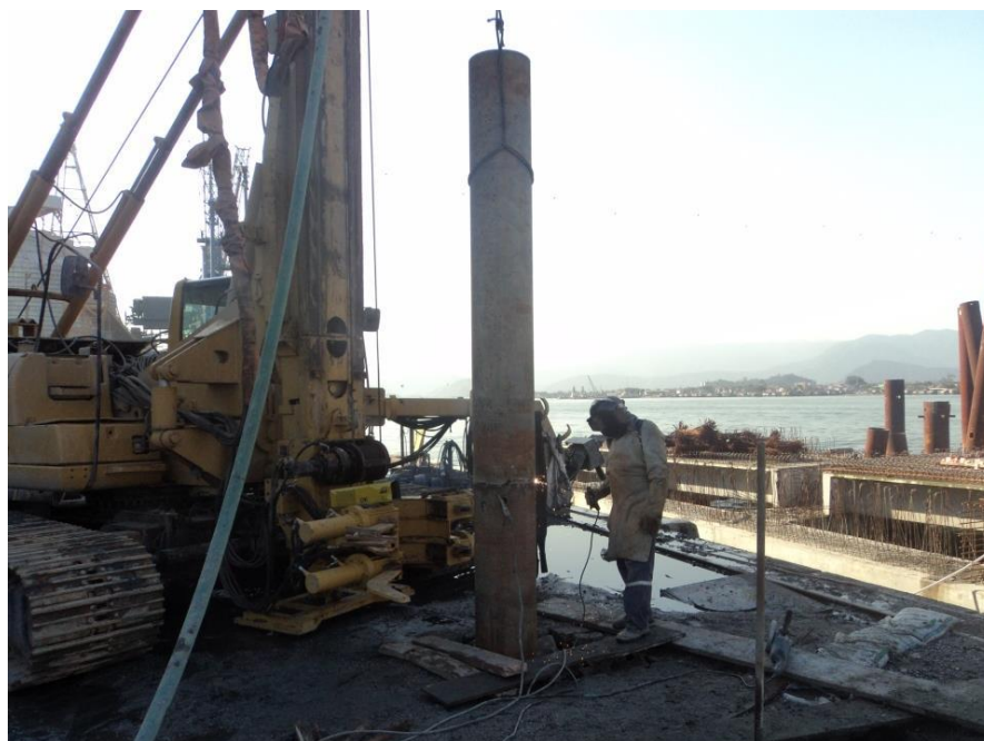
Figura 8: Solda de segmentos de camisas perdidas Fonte: Do autor
