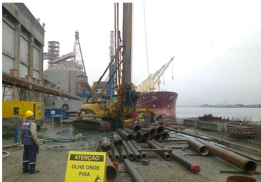
Figura 12: Retirada apenas do revestimento Fonte: Do autor
