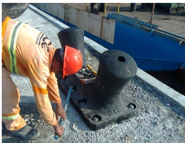
Figura 15: Cabeço de atracação Fonte: Do autor
