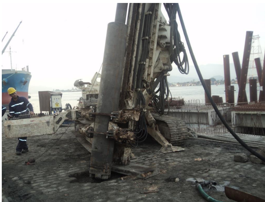
Figura 9: Execução da perfuração Fonte: Do autor
