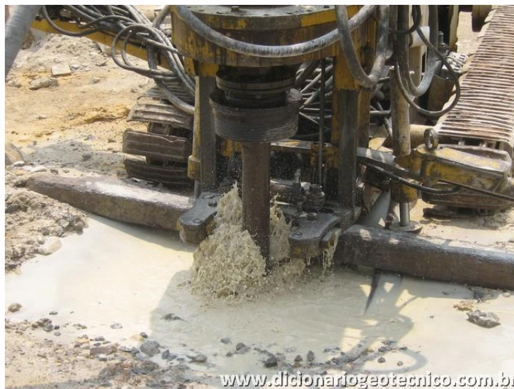
Figura 3: Perfuração com circulação d'água
