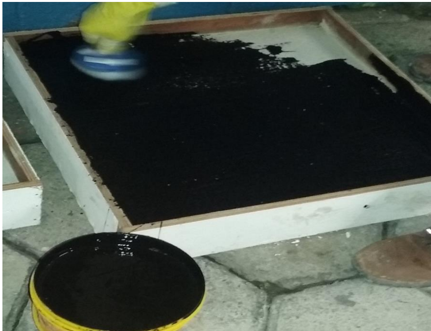
Foto 1 – Execução da impermeabilização
