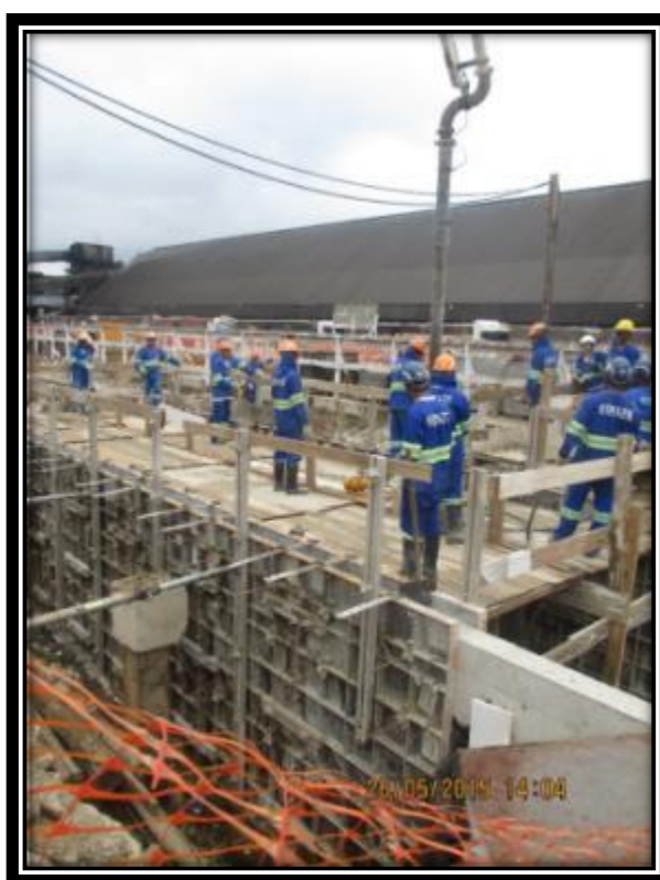
Figura 17- Concretagem da parede do túnel. .
