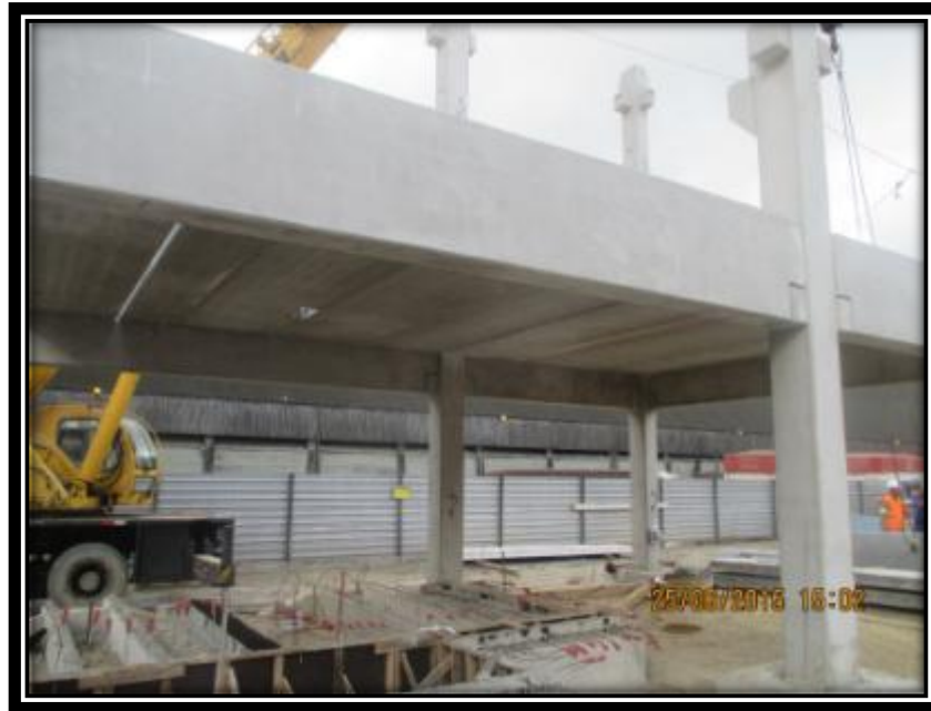
Figura 42 - Montagem de vigas e lajes pré-moldadas. .
