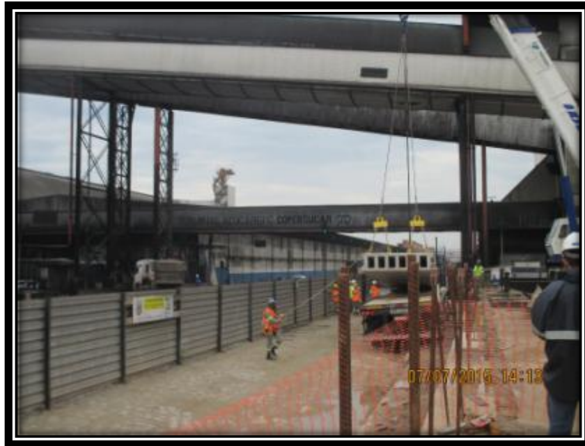
Figura 29- Retirada das paredes pré-moldadas da carreta. .
