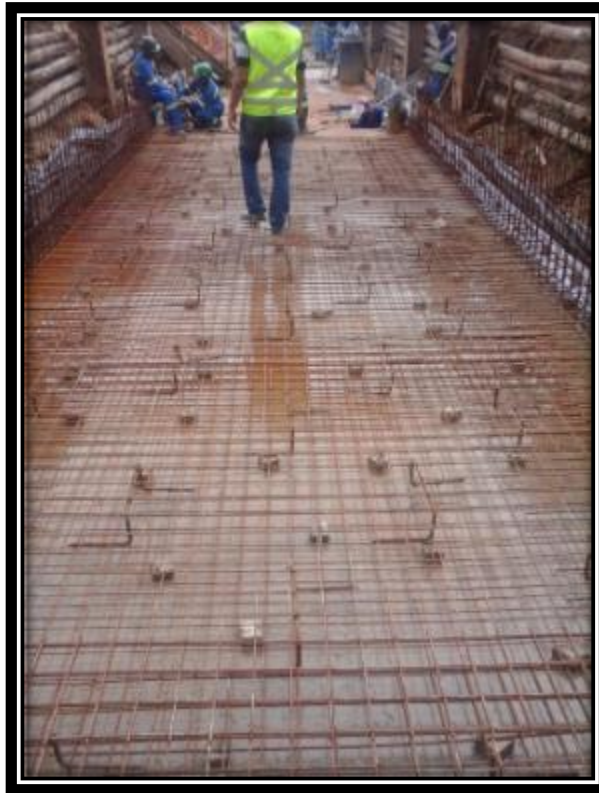
Figura 15- Armadura do piso de fundo do túnel.
