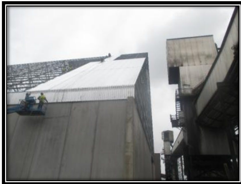
Figura 40 - Montagem das telhas, técnica de Ancoragem. .
