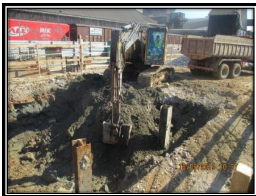
Figura 10 - Escavação do túnel.
