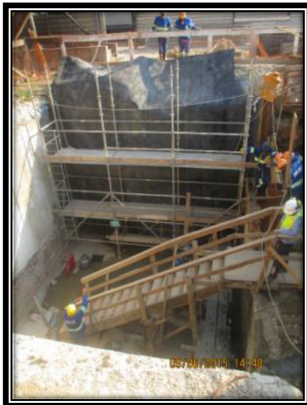
Figura 22- Lançamento de Manta PEAD, para proteção de manta asfáltica. .
