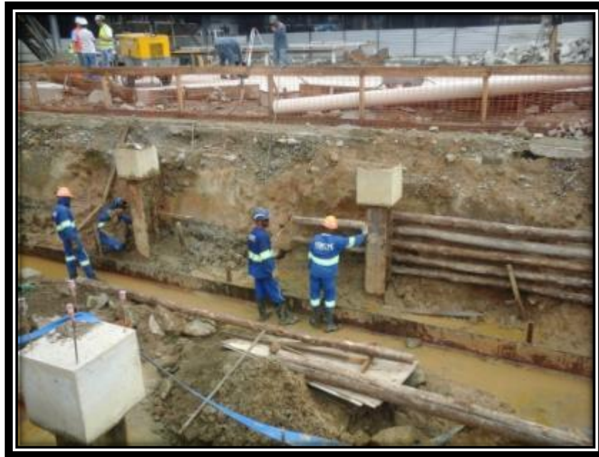
Figura 11 - Escoramento utilizados para segurança na realização do trabalho interno dos túneis. .
