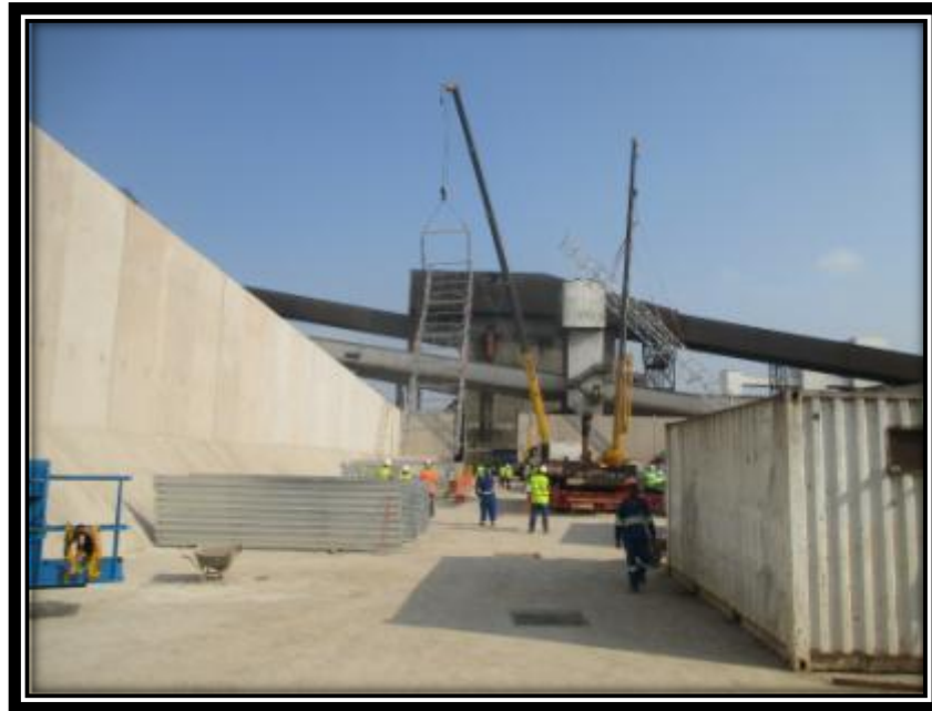
Figura 37- Primeiro módulo içado e travado, e em seguida o segundo módulo. .
