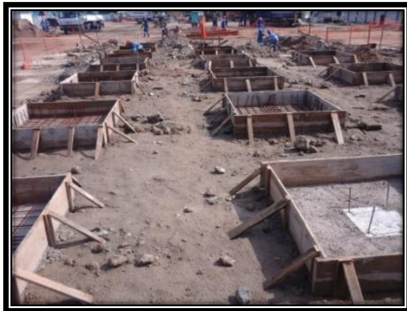
Figura 8 - Capitéis armados sobre os blocos das estacas.
