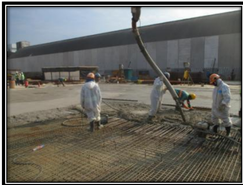
Figura 24 - Concretagem de trecho do piso do armazém. .
