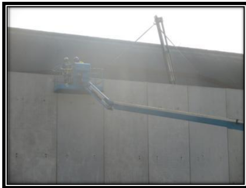
Figura 36 - Instalação de armadura da viga superior das paredes pré-moldadas. .
