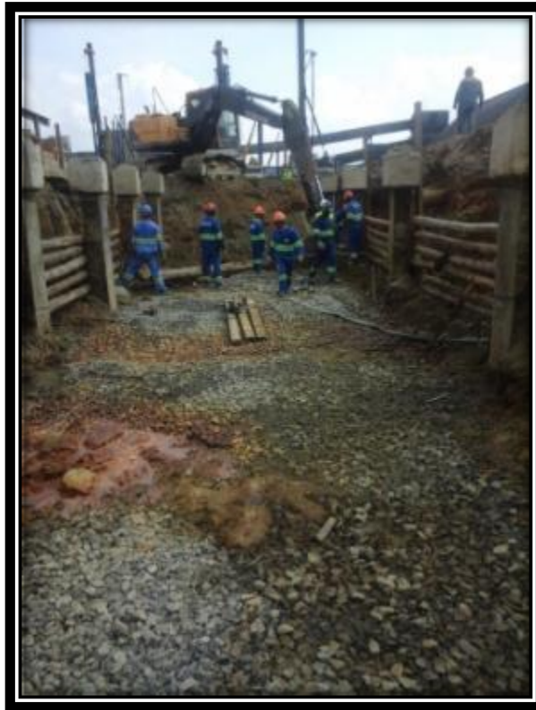
Figura 12 - Lançamento de brita n.º3 para regularização do piso.
