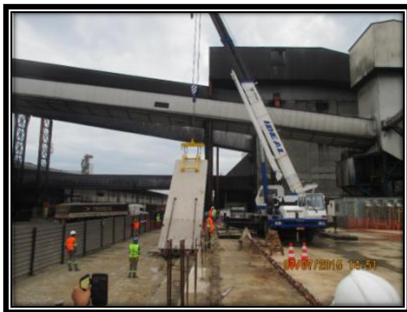
Figura 30- Com as escoras instaladas, inicia-se o processo de verticalização das placas. .
