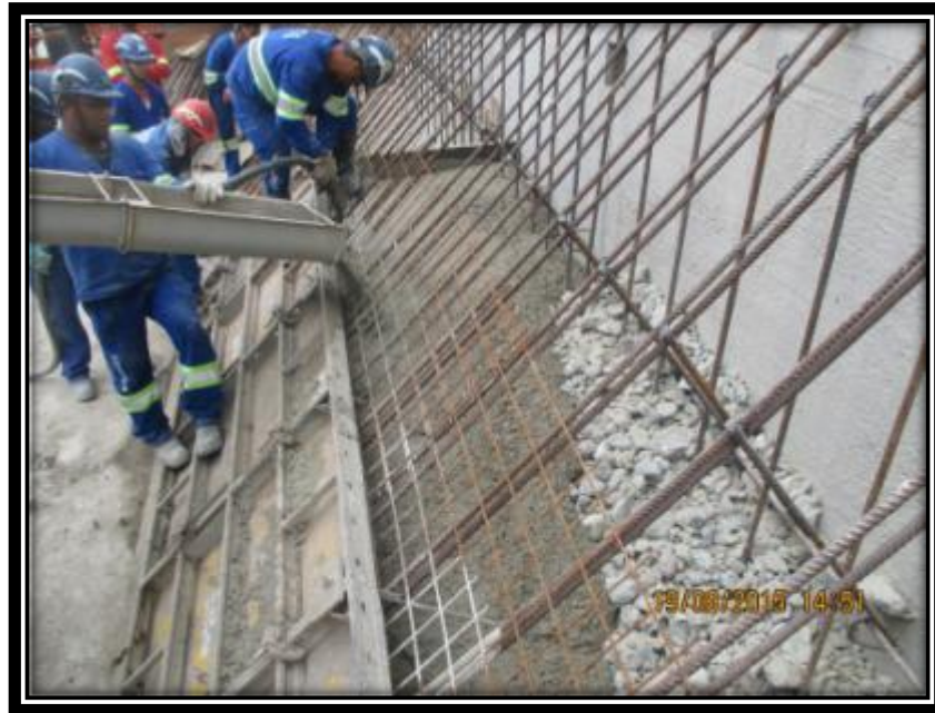
Figura 32 - Concreto ciclópico das mísulas. .
