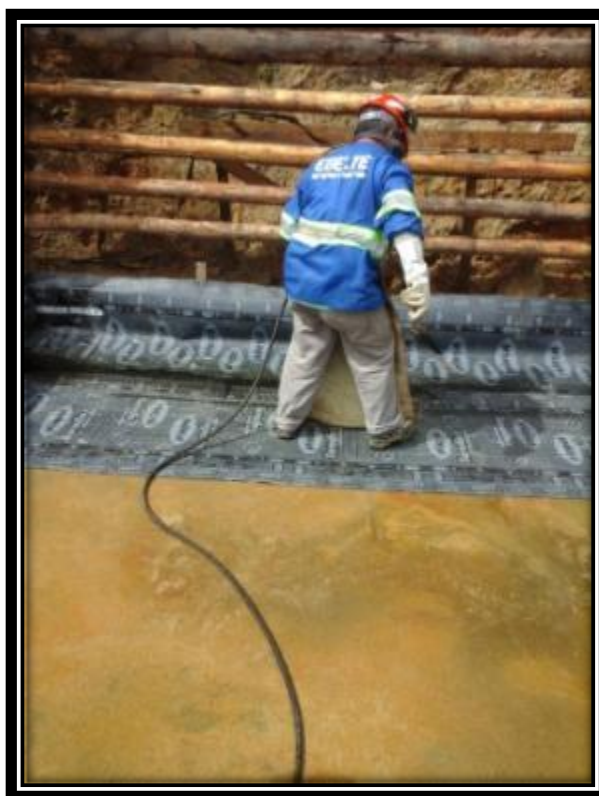
Figura 14- Impermeabilização dos túneis.
