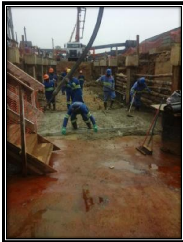
Figura 13- Com auxílio de bomba lança, é executado o lastro da laje de fundo do túnel.
