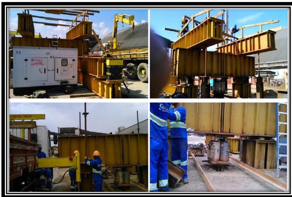
Figura 6 - Execução de ensaio estático de carga nas estacas. .
