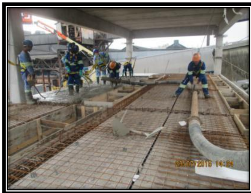
Figura 43- Concretagem do piso sobre a laje alveolar. .
