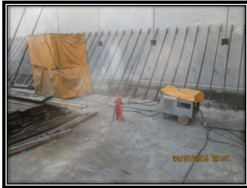
Figura 33 - Tirantes instalados e soldados. .
