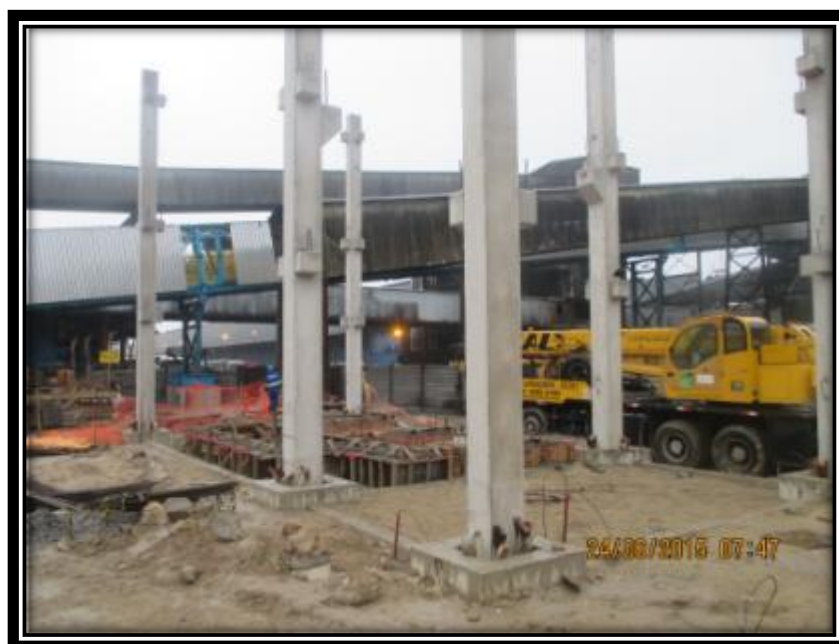
Figura 41 - Montagem dos pilares pré-moldados da subestação. .
