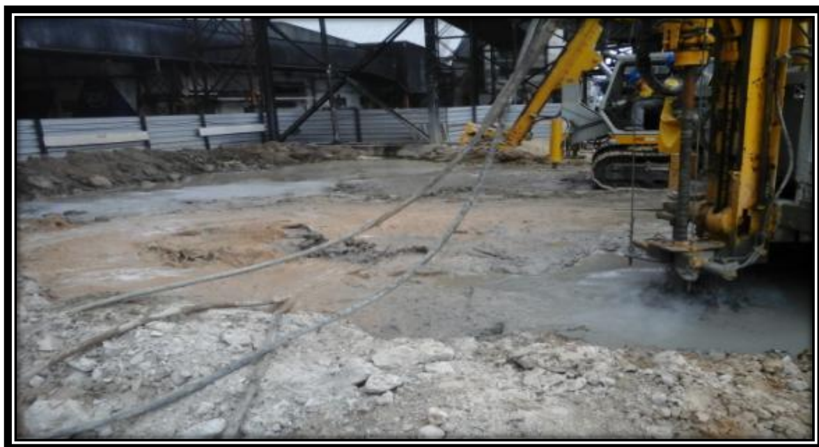
Figura 21 - Máquina realizando injeção de cimento (Jet-grouting do poço do elevador Sul). .
