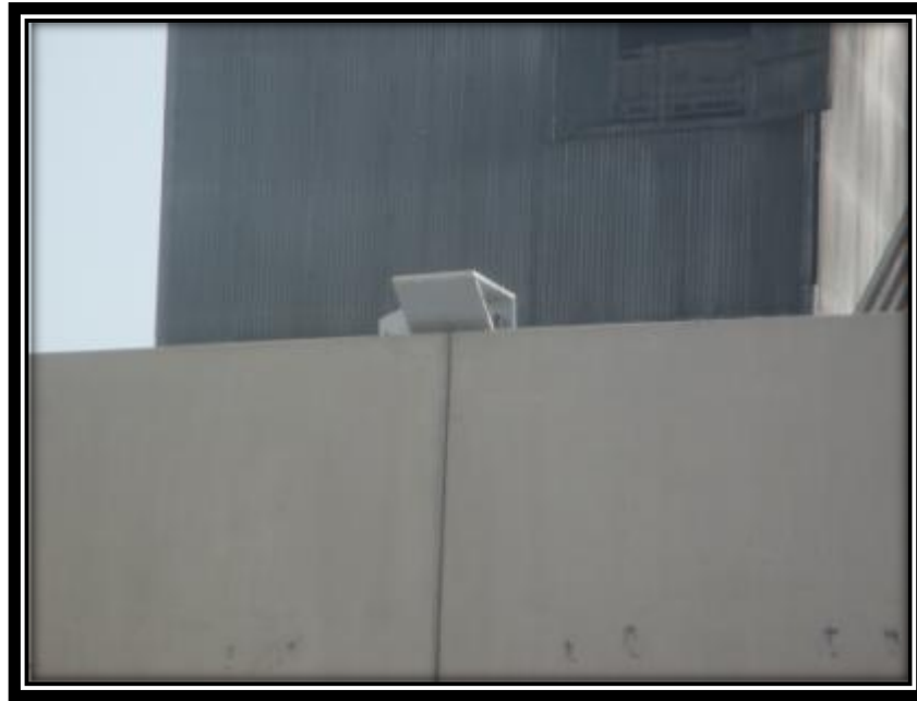
Figura 35- Detalhe da base de apoio para os módulos da estrutura metálica. .
