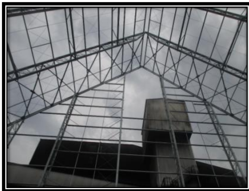
Figura 39 - Detalhe dos contraventos do oitão sul do Armazém. .
