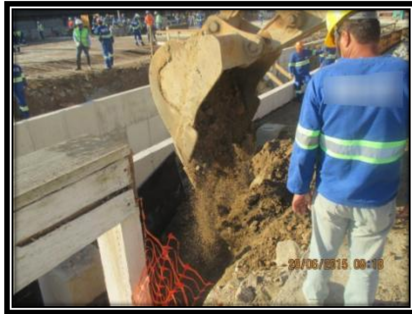
Figura 20 - Reaterro do túnel. .
