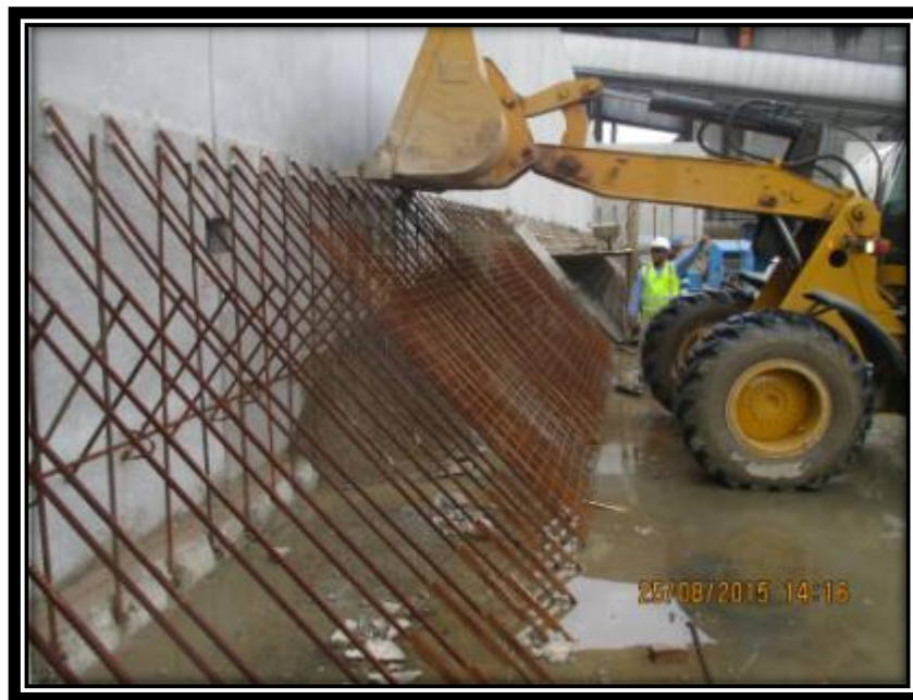
Figura 34 - Lançamento de concreto farofa. .
