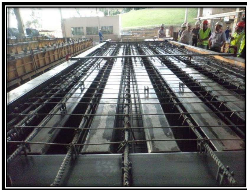
Figura 26- Vista superior da fôrma metálica. .
