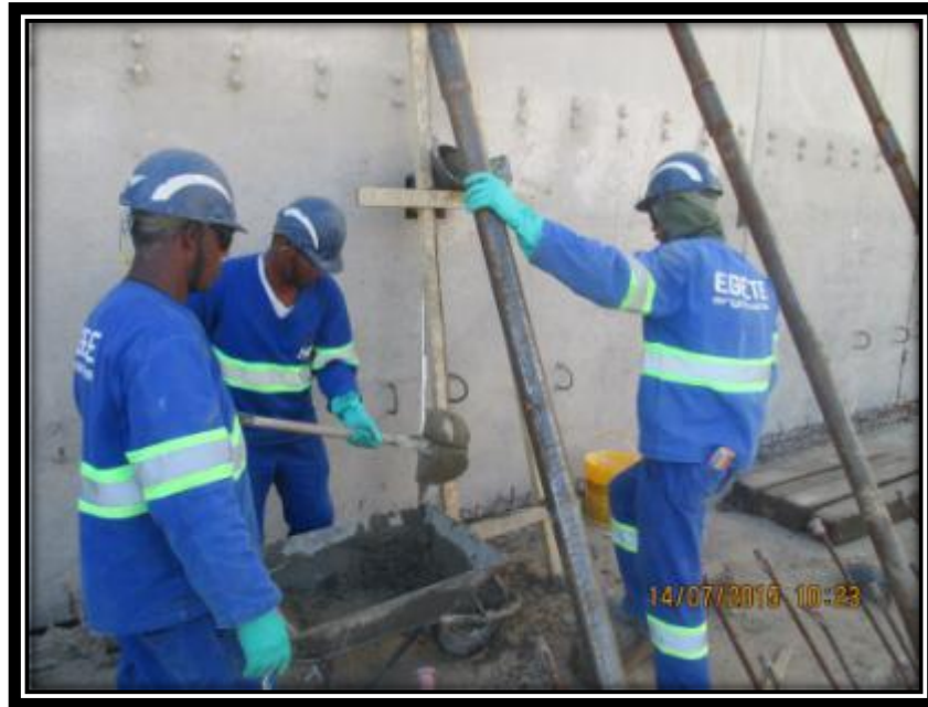
Figura 31 - Concretagem dos pilaretes entre os painéis. .
