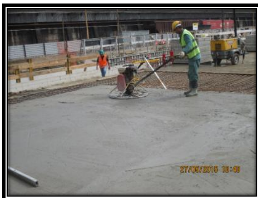
Figura 25 - Acabamento final da concretagem de trecho do piso.
