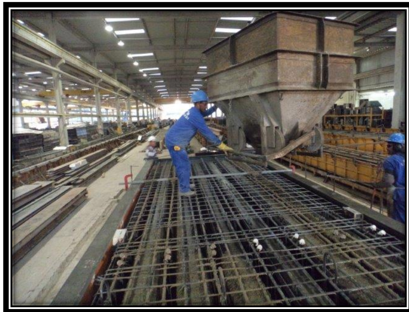
Figura 27 - Concretagem das paredes pré-moldadas. .
