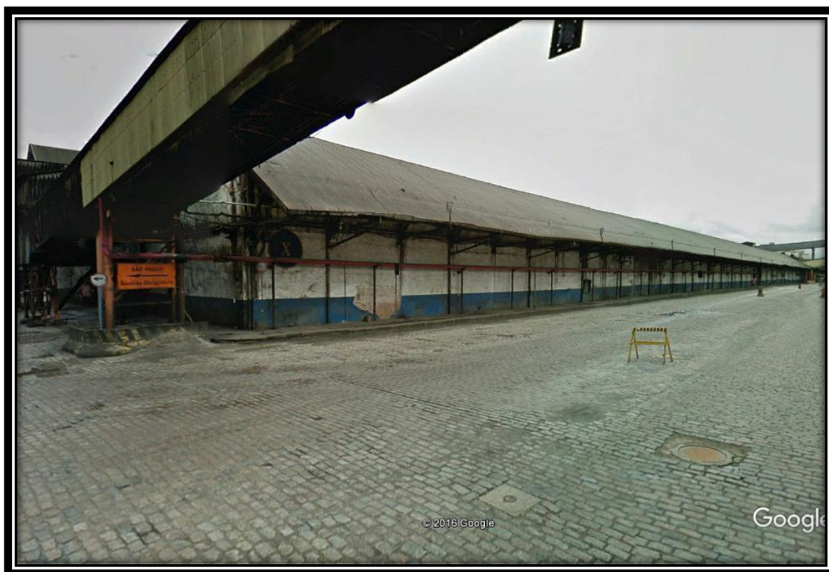
Figura 1 - Foto do armazém antes do incêndio .Fonte: Google Earth.
