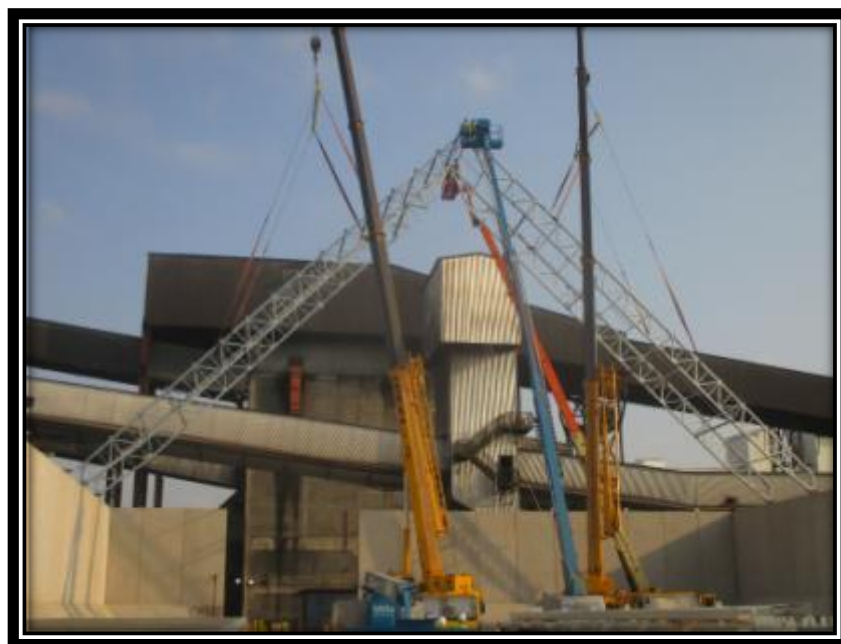
Figura 38 - Travamento entre os dois módulos. .
