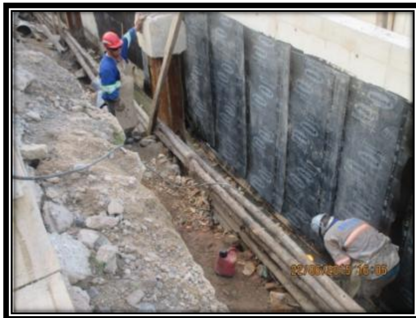
Figura 18 - Impermeabilização da parede do túnel. .
