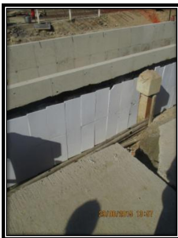
Figura 19 - Proteção mecânica EPS da parede do túnel. .
