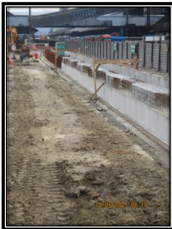
Figura 23 - Detalhe de metade da viga concretada. .
