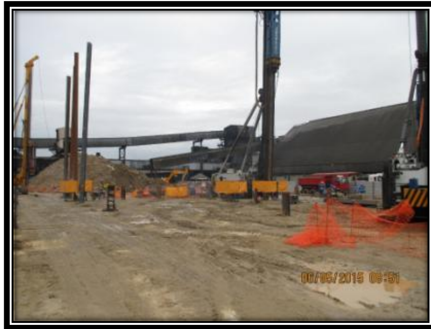
Figura 7 - Cravação de estacas. .
